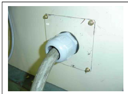
Fig. 2 Fitting a conduit
